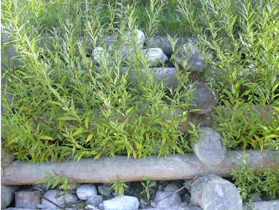
Bild K1: Die Buschlagen aus Korbweide in dieser Krainerwand haben schon nach kurzer Zeit kräftig ausgetrieben.
